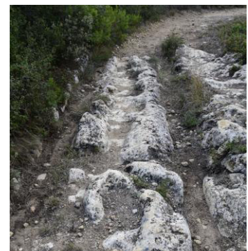
Ornières situées à proximité de Saint-Paul le Marseillais à Mèze, sur la tracé de la LGV
